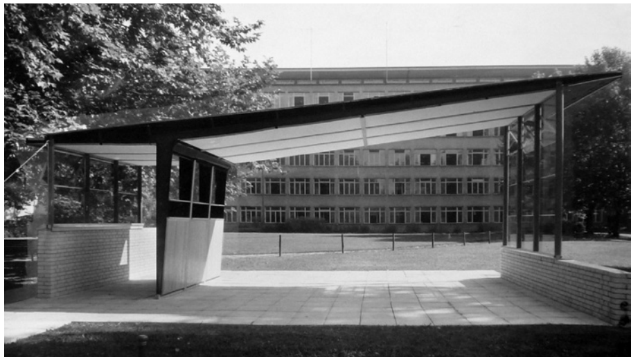
Figura 3. Jean Prouvé, Tre campate del sistema coque allestite nel cortile del Kunstgewerbemuseum, Zurigo, 1953 (gta Archiv, Fondo Alfred Roth).
