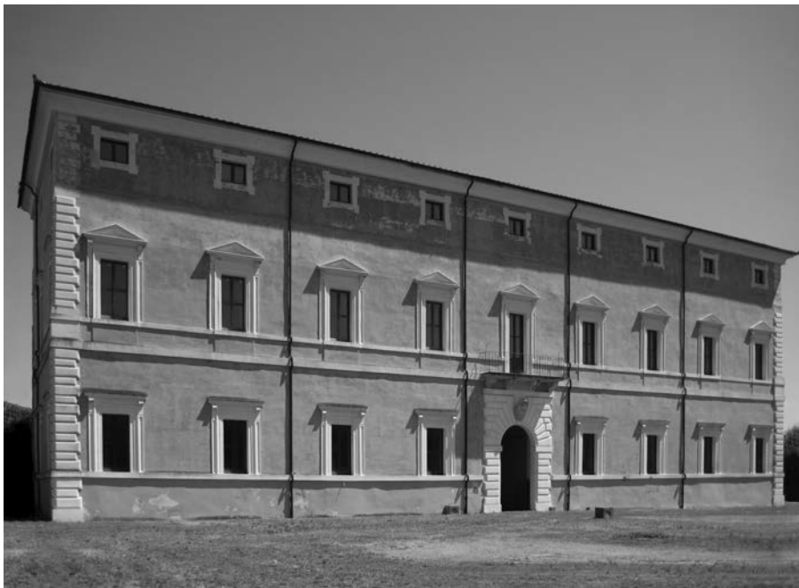
Fig. 5 La Sforzesca, Castell'Azzara, il prospetto principale dopo gli interventi di restauro, 2008.
