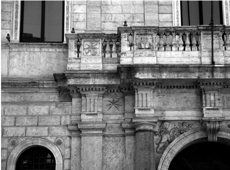
Fig. 20. Roma, palazzo della Cancelleria, dettaglio del portale inserito da Domenico Fontana nella facciata quattrocentesca.
