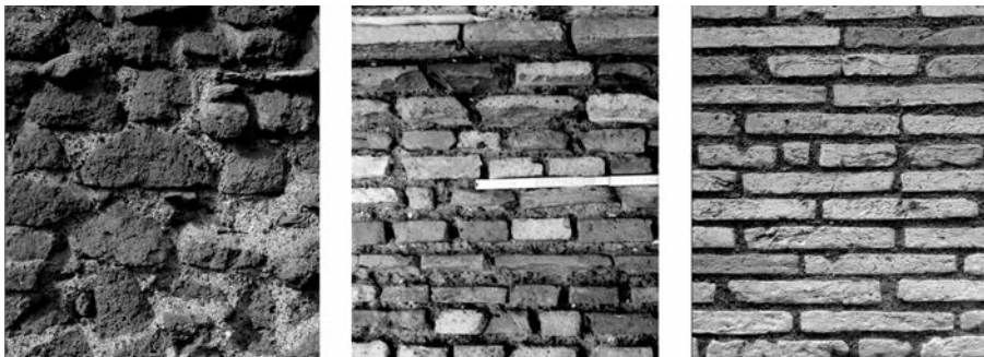
Fig. 8. Macchine murarie romane (da Porta Portese e Sant' Andrea delle Fratte).
