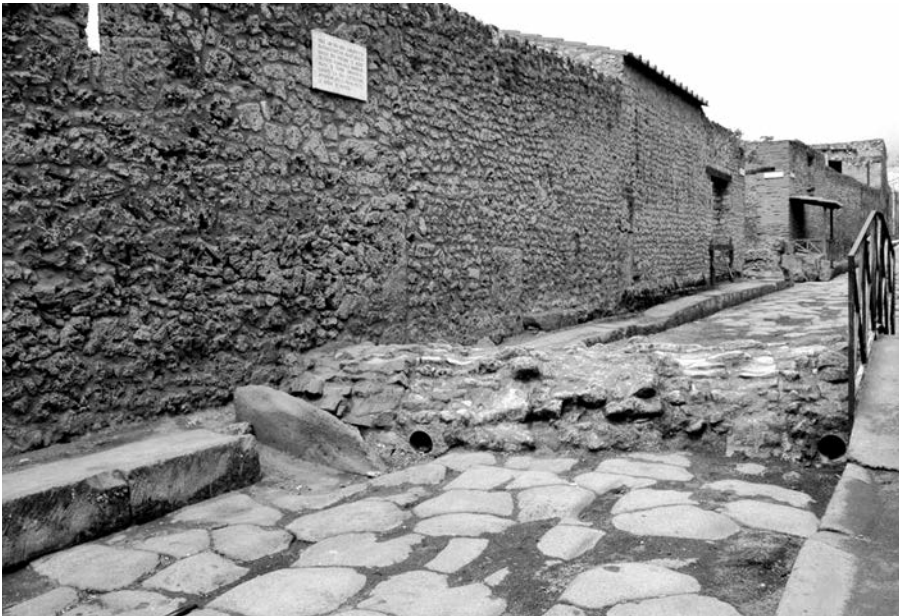
Fig. 7. Via Nocera. Estradosso del cunicolo.
