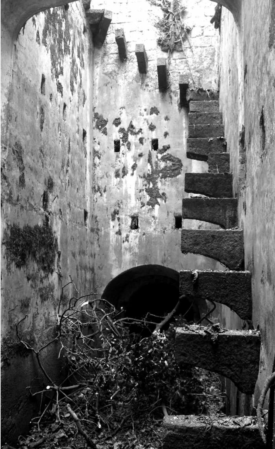
Fig. 10. Reg. I - Pozzo/vasca 5. Particolare delle scale litiche a sbalzo.
