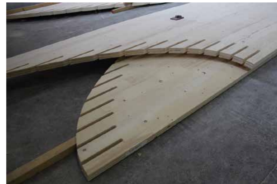
_ Figura 4. Padiglione per Mendrisio, particolare della giunzione a coda di rondine (IBOIS).
