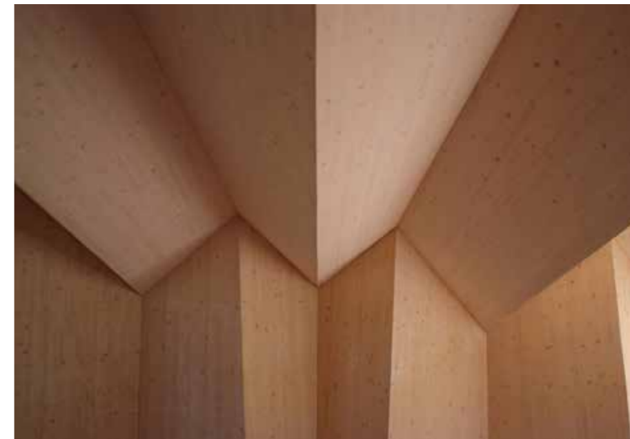
Figura 10. Cappella St. Loup, particolare della congiunzione tra parete e copertura della struttura piegata (foto Fred Hatt).
