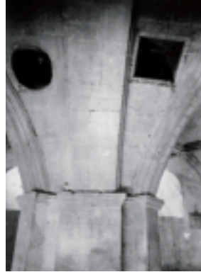
Figura 7. Trani, San Nicola Pellegrino e Santa Maria, apertura nella volta della cripta dal corpo longitudinale (foto A. Klein 2011).
