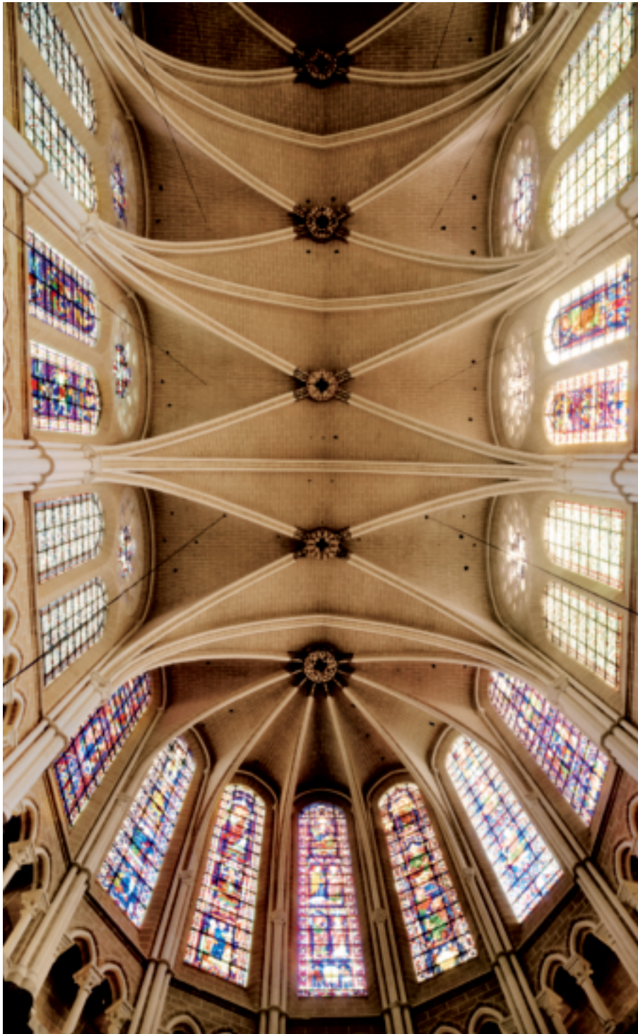
_Abbildung 7. Chartres, Kathedrale, Blick in den Hochchor und das Gewölbe, Zustand nach der Restaurierung des Obergadens (foto A. Schiffhauer 2010).
