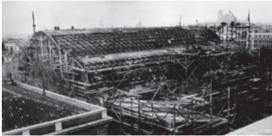
— Eduardo Torroja e Secundino Zuazo, veduta del cantiere e interno del Frontón Recoletos, Madrid, 1935 (da J.A. Fernández Ordóñez, J.R. Navarro Vera, Eduardo Torroja Ingeniero , Pronaos, Madrid 1999, p. 71). — Eduardo Torroja e Secundino Zuazo, Frontón Recoletos, sezione trasversale e schema di funzionamento del modello in scala 1:10 in microcalcestruzzo della copertura del Frontón Recoletos ( ibidem , pp. 133, 74).
