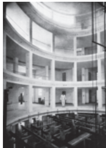
_ Vista esterna e interna della grande torre sperimentale dell'ISMES, 1953.
