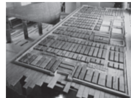
_ Modello di solaio tipo della Torre Galfa in scala 1:5 durante il confezionamento e le fasi di prova, 1957 (Archivio Storico ISMES).
