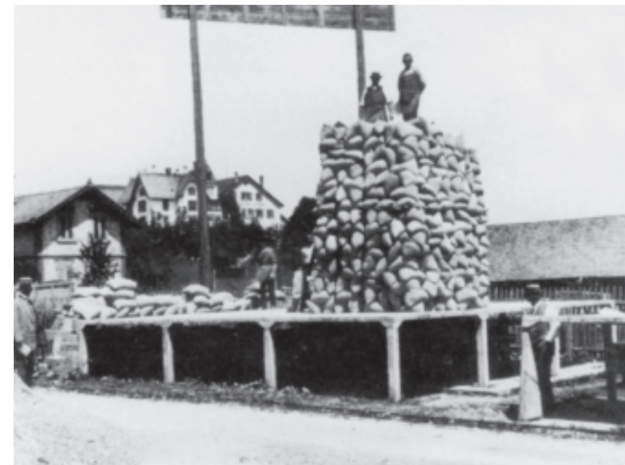
— Robert Maillart, prove di carico su una soletta in cemento armato, Zurigo, 1908.
