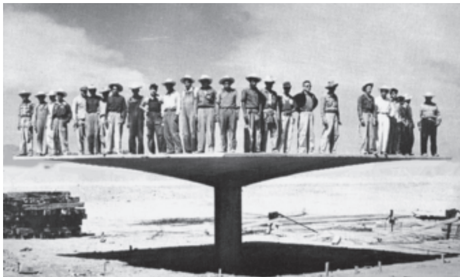
_ Félix Candela, "Ombrello" sperimentale in cemento armato, Colonia Vallejo, Mexico D.F., 1953.
