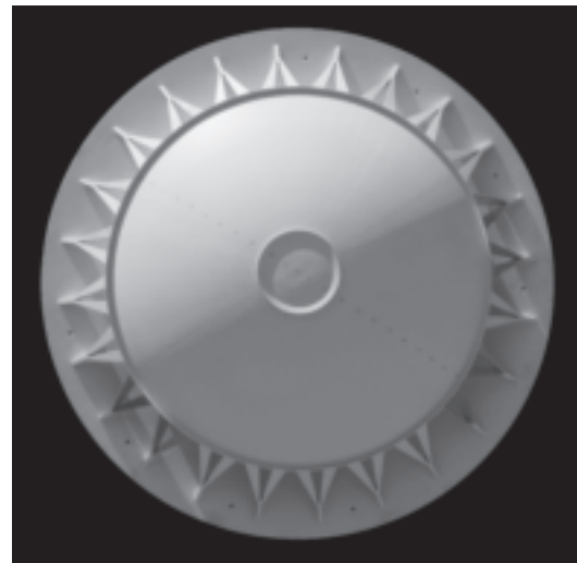
_ Modello in scala 1:50 della Norfolk Scope Arena durante le prove di carico, 1967 (Archivio Storico ISMES).
