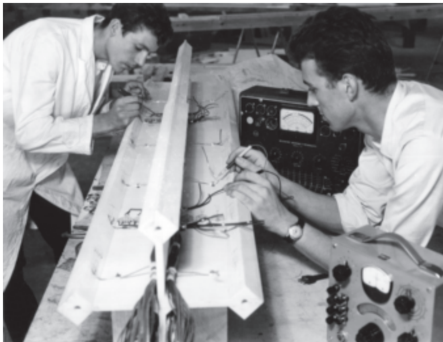
_ Confezionamento del modello in scala 1:52,8 della Torre di Montreal all'ISMES, 1962 (Archivio Storico ISMES).
