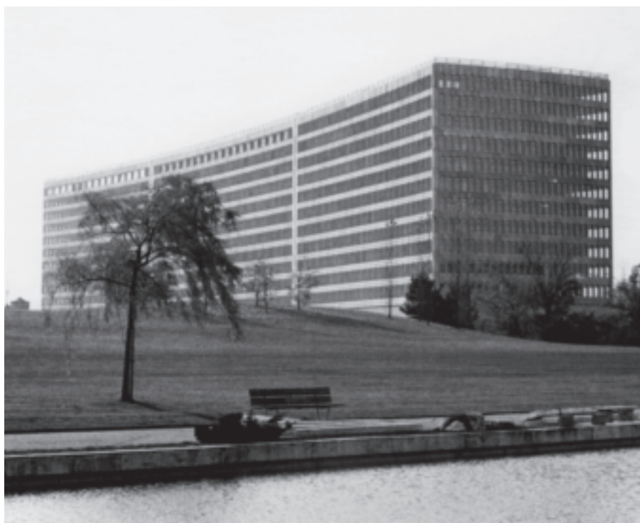
_ Bureau International du Travail (BIT), veduta d'insieme (Archives photographiques de l'OIT, Genève).
