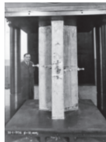
— Modello delle pareti di controvento della Torre Velasca, 1956 (Archivio Storico ISMES). — Modello di un elemento di pilastro della Torre Velasca, 1956 (Archivio Storico ISMES).
