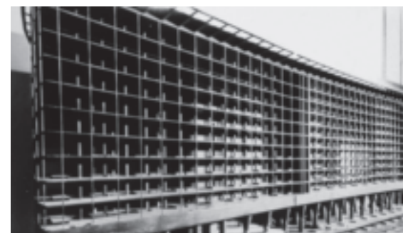
_ Modelli elastici in scala 1:40 della nuova sede del BIT durante le prove all'ISMES (Archivio Storico ISMES).
