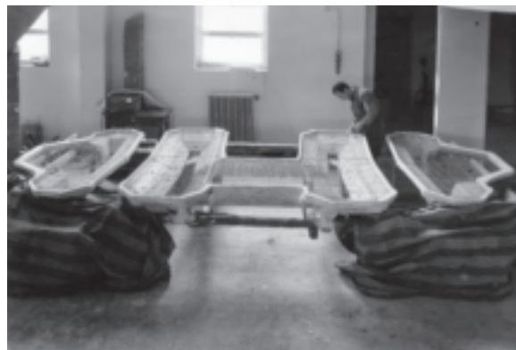
_ Fasi del confezionamento del modello in scala 1:15 del Grattacielo Pirelli, 1955 (Archivio Storico ISMES).
