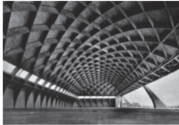
_ Pier Luigi Nervi, Aviorimessa di Orvieto, vista del cantiere e interno. _ Modello in celluloido in scala 1:37,5 dell'Aviorimessa di Orvieto attrezzato per la determinazione degli effetti di peso proprio, 1935-1936.
