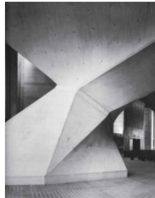
— Dettagli di un pilastro della Cattedrale di San Francisco e del modello in scala 1:15 testato all'ISMES (Archivio Storico ISMES).
