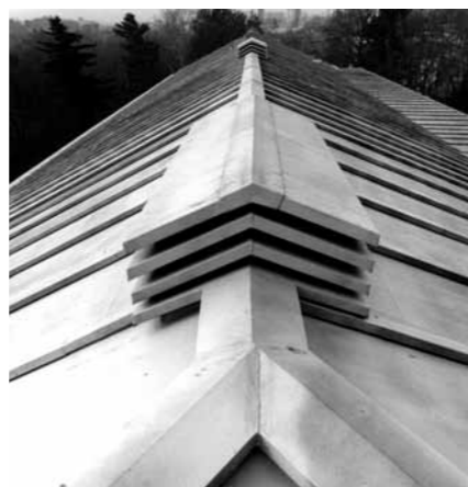
Otto Rudolf Salvisberg, Ospedale Lory a Berna, 1926-1929. Il tetto a falde ha una copertura in rame. (Foto F. Schwendimann). Rifacimento del tetto in rame rispettoso dei dettagli costruttivi e formali. Tschantré Architekten AG. (Foto F. Schwendimann).
