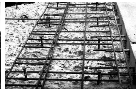
Karl Moser, Chiesa di S. Antonio a Basilea, 1926-1927. I danni della superficie del calcestruzzo sono stati riparati con uno strato supplementare di cemento armato. Restauro 1987-1991. (Foto B. Furrer).
