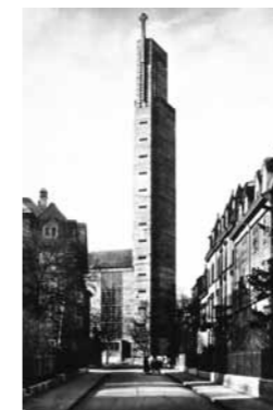
Karl Moser, Chiesa di S. Antonio a Basilea, 1926-1927. I danni della superficie del calcestruzzo sono stati riparati con uno strato supplementare di cemento armato. Restauro 1987-1991. (Foto B. Furrer).
