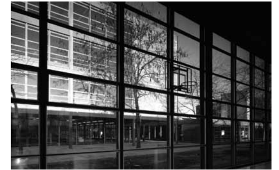
Fritz Haller, Scuola cantonale a Baden, 1964. Restauro Burckhardt & Partner/ Zulauf und Schmidlin, 2005-2007. Curtain walls conservati e muniti di nuovi vetri. Gli edifici corrispondono alle esigenze minerarie. (Foto R. Zimmermann).
