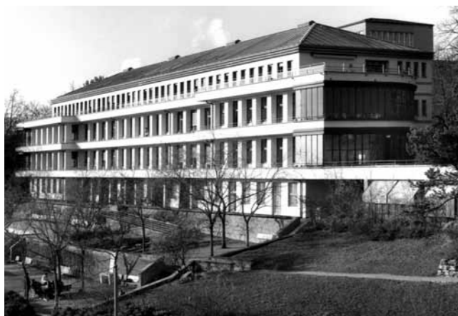
Otto Rudolf Salvisberg, Ospedale Lory a Berna, 1926-1929. Il tetto a falde ha una copertura in rame. (Foto F. Schwendimann). Rifacimento del tetto in rame rispettoso dei dettagli costruttivi e formali. Tschantré Architekten AG. (Foto F. Schwendimann).
