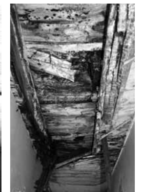
Carl Weidemyer, Teatro San Materno ad Ascona, 1928. Tetto piano e soffitto rovinati a causa della mancanza di manutenzione. (Foto B. Furrer).
