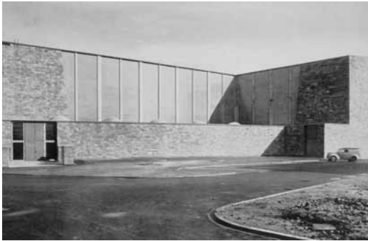
Rudolf Schwarz, Chiesa di Sant'Anna in Düren, 1951-1956, la parete di vetrocemento prima e la vetrata artistica dopo il "restauro".
