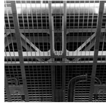
Fritz Haller, sistema costruttivo modulare in acciaio "MIDI", 1980, vista del soffitto tecnico.
