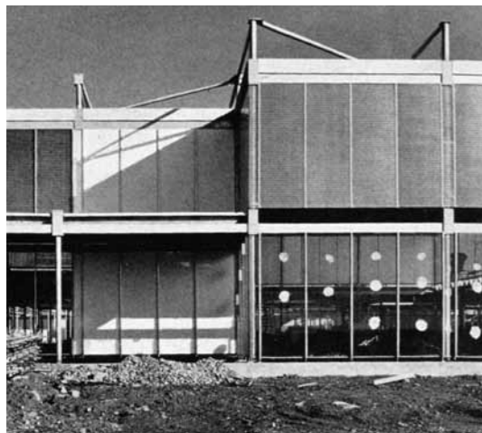
Max Bill, padiglione B2 all'Expo 64 di Losanna, durante la costruzione.
