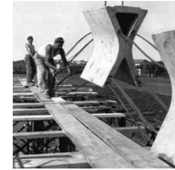
Angelo Mangiarotti, Chiesa Mater Misericordiae a Baranzate, 1957, immagine del cantiere.
