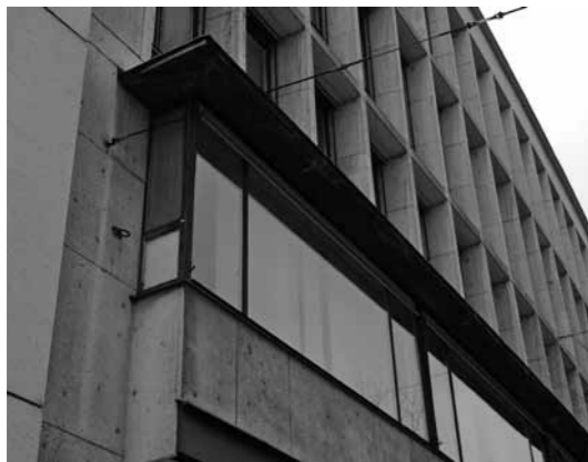
Otto Rudolf Salvisberg, Bleicherhof a Zurigo, 1939-1940. Serramento originale termicamente migliorato sostituendo il vetro semplice con un vetro isolante. (Foto B. Furrer).
