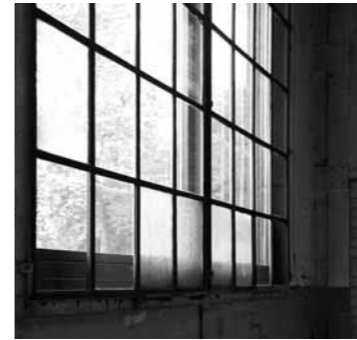
Ex capannone per la costruzione di scambi von Roll a Berna, 1914. Restauro Giuliani-Hönger, 2008-2010. Serramento in ferro con vetro semplice, mantenuto applicando un serramento esterno supplementare. (Foto B. Furrer).
