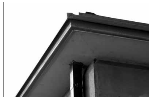
Hans Merz, Villa Büchi a Berna, 1932. Restauro Feissli-Gerber, 2002. Bordo di un tetto piano con dettagli originali ripristinati. (Foto B. Furrer).
